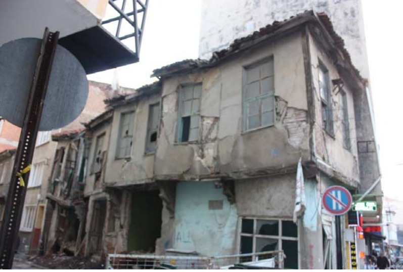
19. Resim: Karakaş Mahallesi Eski Hapishane Sk.No:25
