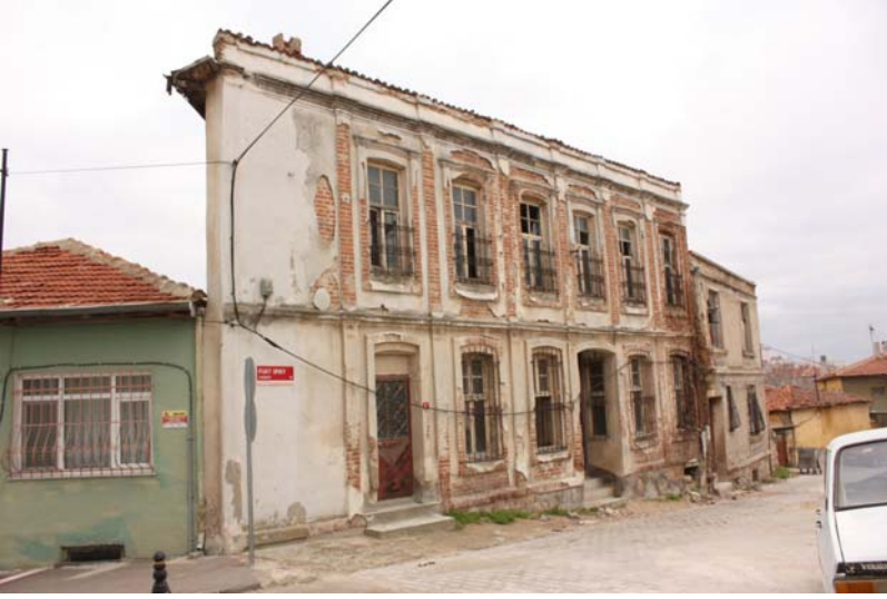
23. Resim: Demirtaş Mahallesi Fuat Umay Cad.No:1
