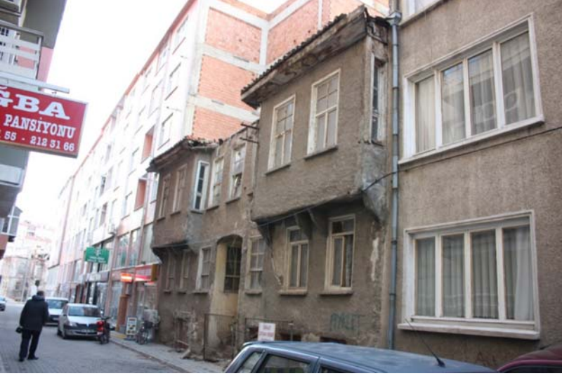
18. Resim: Karakaş Mahallesi Eski Hapishane Sk. No:21
