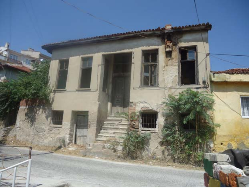
24. Resim: Demirtaş Mahallesi Fuat Umay Cad.No:12
