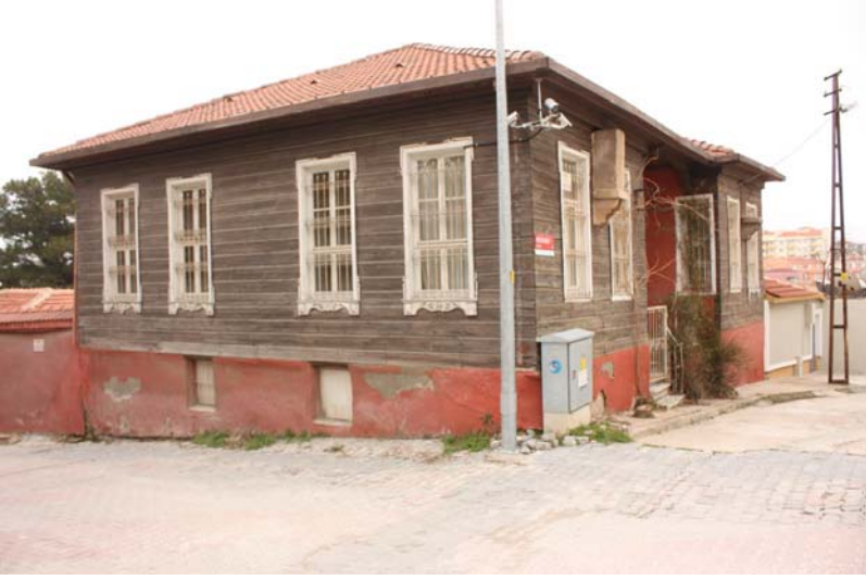
9. Resim: Yayla Mahallesi Merdivenli Sk.No:1
