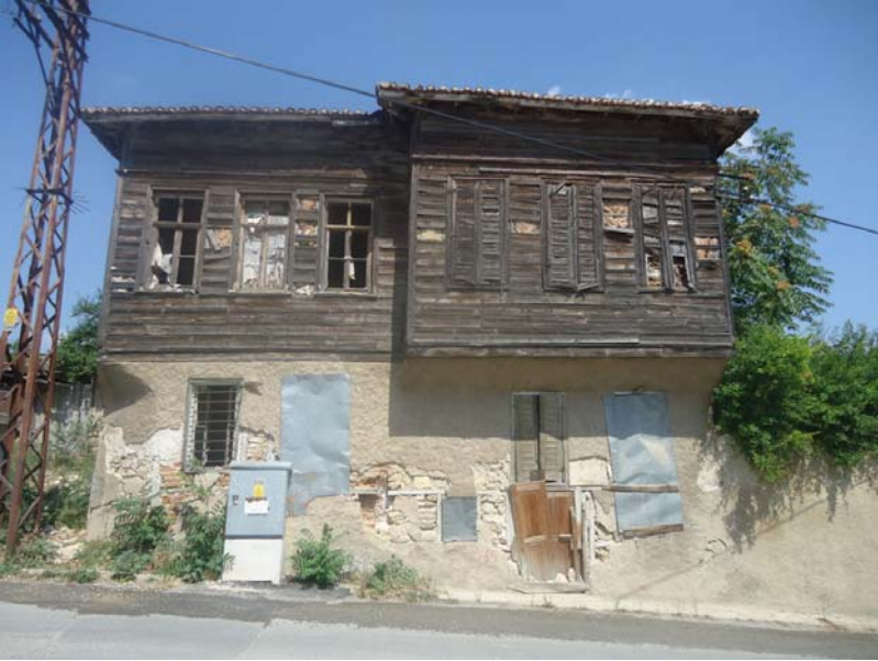
30. Resim: Akalar Mahallesi Dilber Sk.No:13
