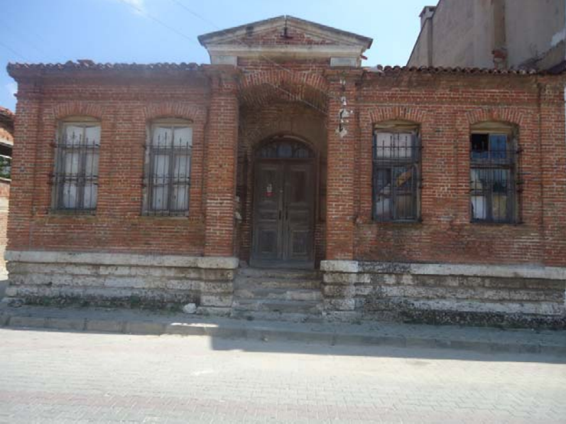
26. Resim: Demirtaş Mahallesi Koşuyolu Ara Sk.No:15
