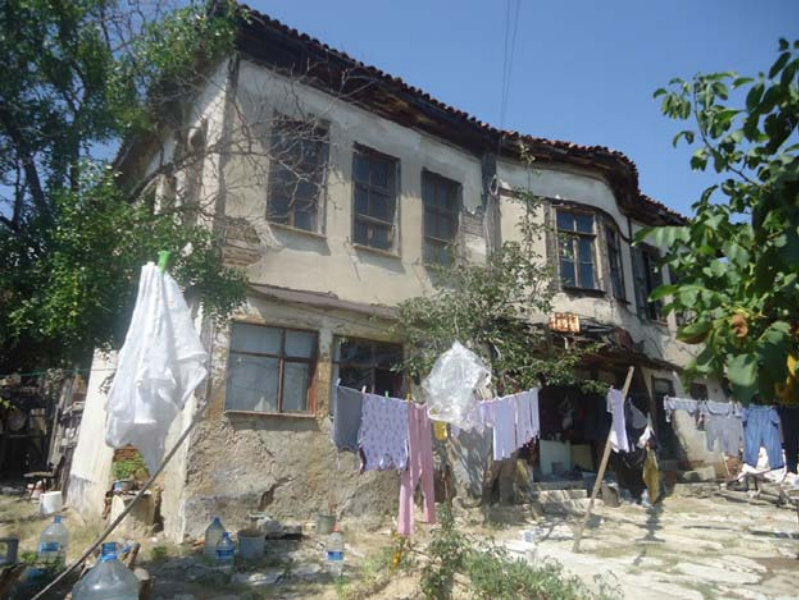
28. Resim: Akalar Mahallesi Dilber Sk.No:11
