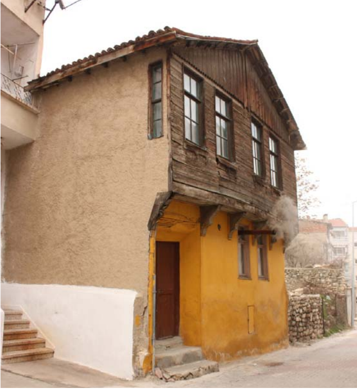
25. Resim: Demirtaş Mahallesi Hacı Hasan Çeşme Sk.No:10
